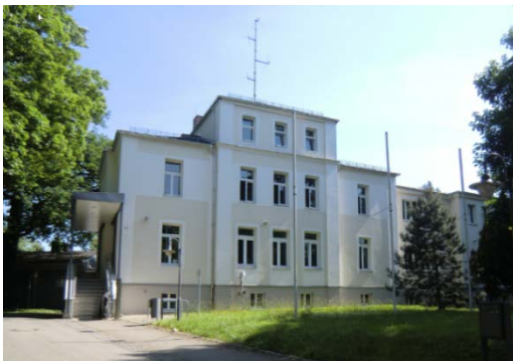
Abbildung 10: Polizeirevier Dresden Mitte, nach der Sanierung
