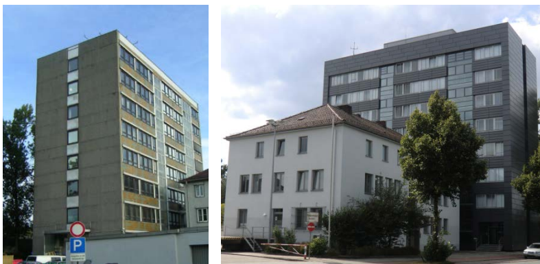
Abbildung 12: Zollamt Bremen, links vor und rechts nach der Sanierung
