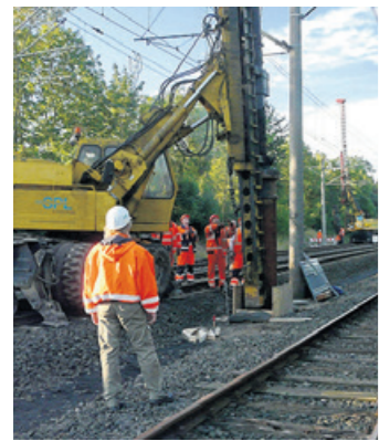
Neue Mastfundamente werden gesetzt.
