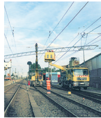
Montage neuer Oberleitungen an der Strecke der Linie 16
