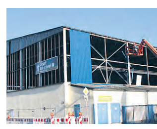
Die Umbauarbeiten laufen an der Hillebrandt-Halle.
