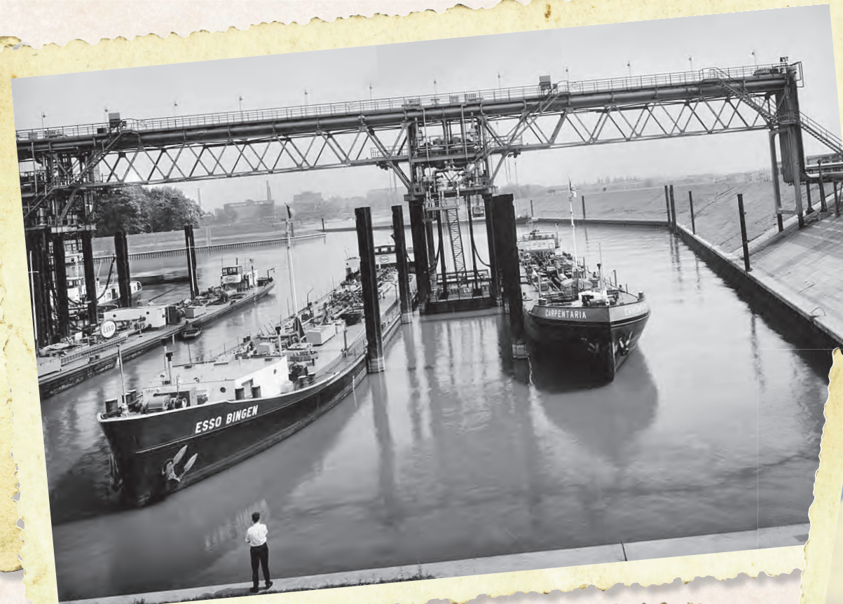
Der Hafen Niehl II wurde für die Esso-Raffinerie gebaut.
