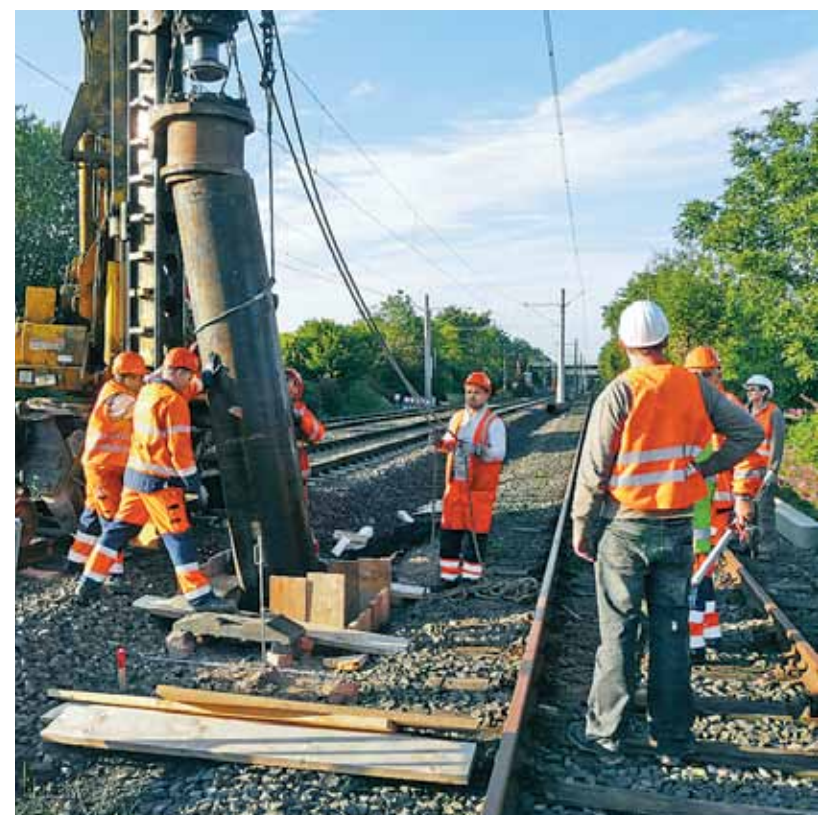
Bevor die Masten stehen, werden die Pfeiler in den Boden gerammt. Dafür benutzt die HGK großes Gerät.
