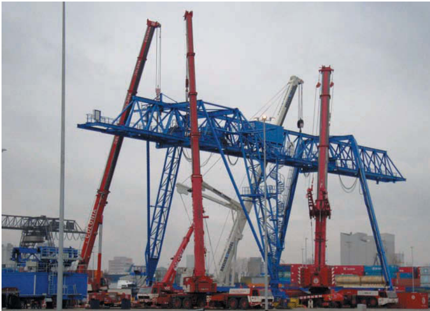
Im November 2009 montierte der Kranhersteller Ardel eine neue Container-Brücke für das Maersk-Terminal in Neuss.
