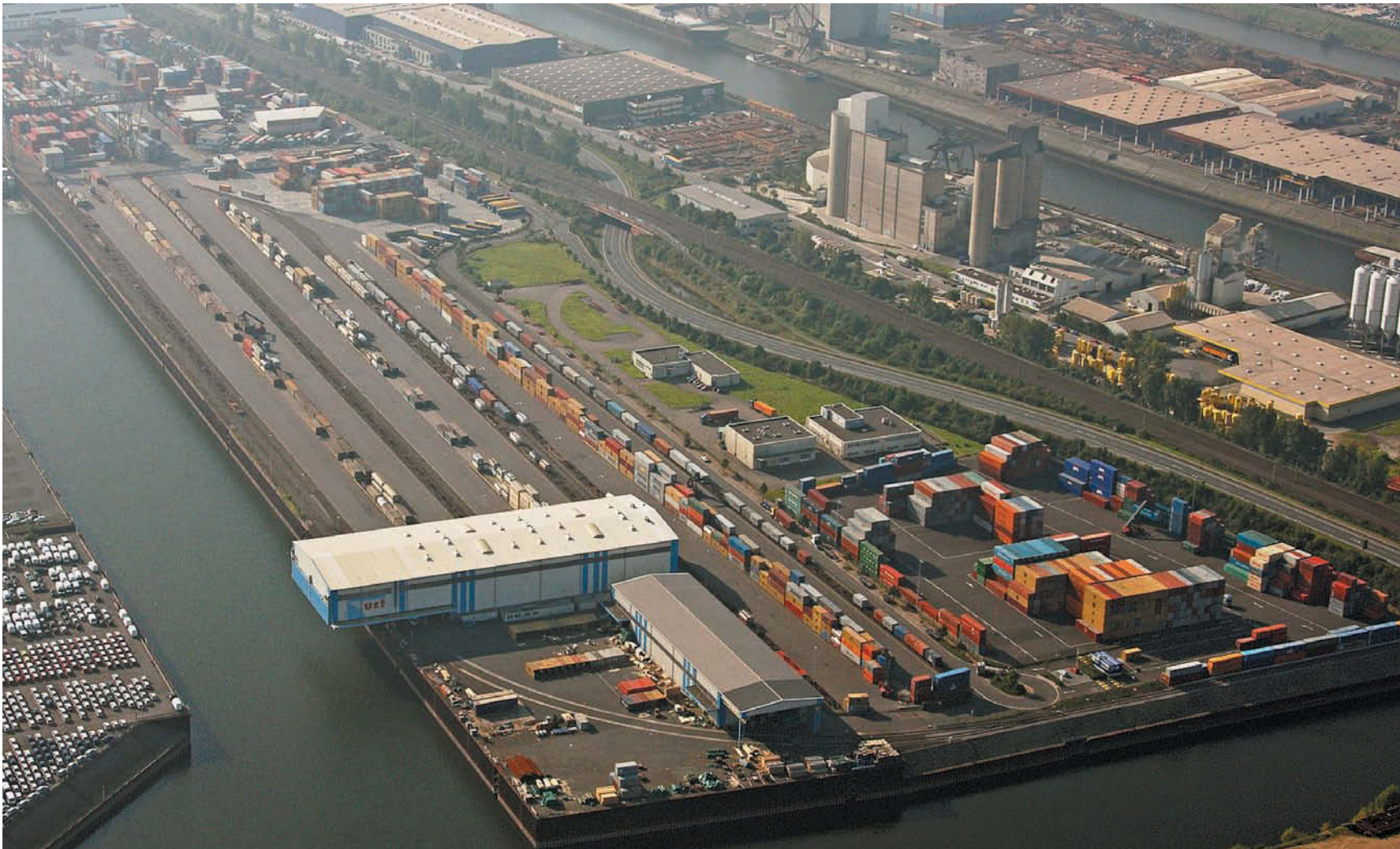
Das Terminal Neuss Trimodal startete 1985 auf 7.500 Quadratmetern. Steigender Bedarf ließ den Umschlagsstandort auf heute 133.073 Quadratmeter anwachsen.
