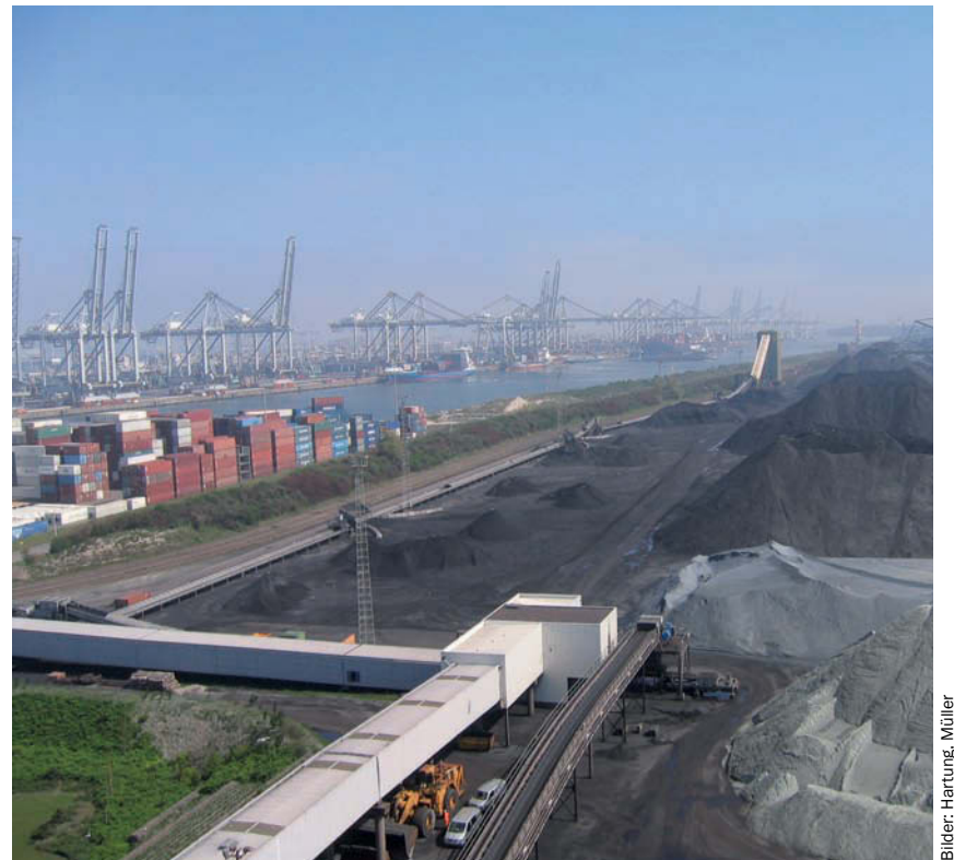
Das Importkohlelager der Firma EMO in Rotterdam.
