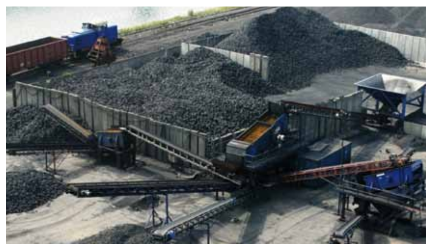
Kohlemischanlage der HTAG im Hafen Duisburg.
