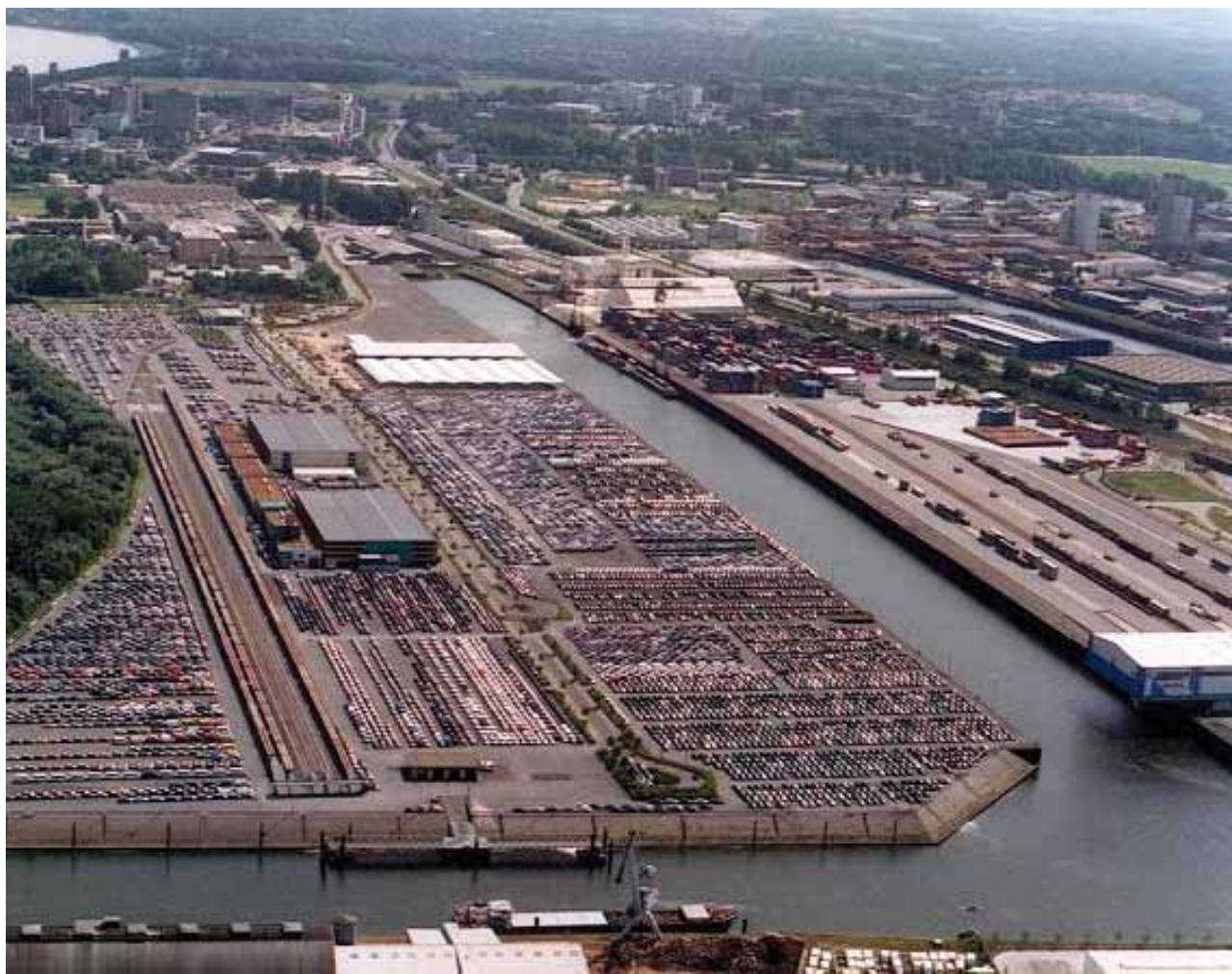
Mit gigantischen Ausmaßen: das BGL-Autoterminal in Neuss.
