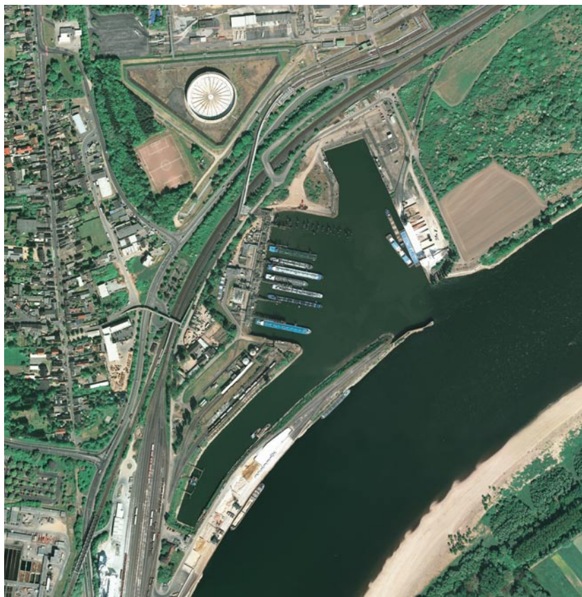
Der Godorfer Hafen soll um ein weiteres Becken erweitert werden.
