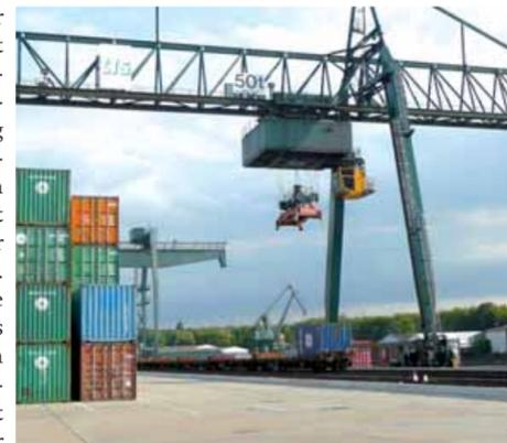
Die bis zu 60 Zentimeter dicken Stahlbetonplatten können jeweils bis zu vier Container mit einem Gesamtgewicht von maximal 176 Tonnen tragen | Bild: Dünner
