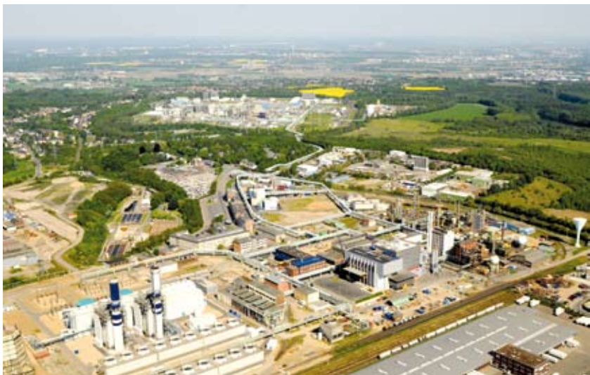
Der InfraServ Chemiepark Knapsack | Bild: InfraServ
