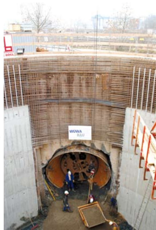
4,8 Meter Durchmesser hat der neue Tunnel | Bilder: Basell
