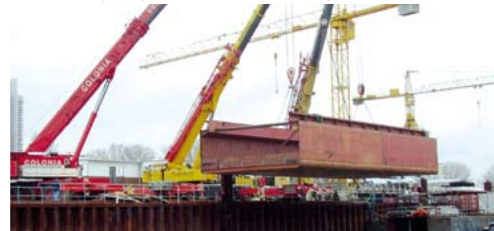
die an Land vorgefertigte neu Mittelsektion wird eingeschommen ...
