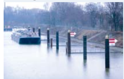
Der auf acht Dalben erweiterte Liegeplatz für Gefahrgutschiffe im Hafen Mülheim
