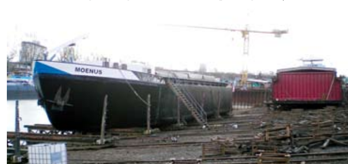
und auf der Helling in den getrennten Schiffskörper eingebaut | Bilder: KSD
