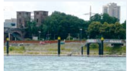
Der neue Autoabsetzplatz südlich des Rheinauhafens | Bilder: WSA Köln
