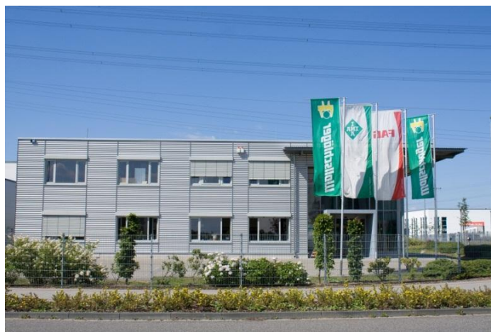
Firma Wollschläger (Quelle: TROWISTA GmbH)
