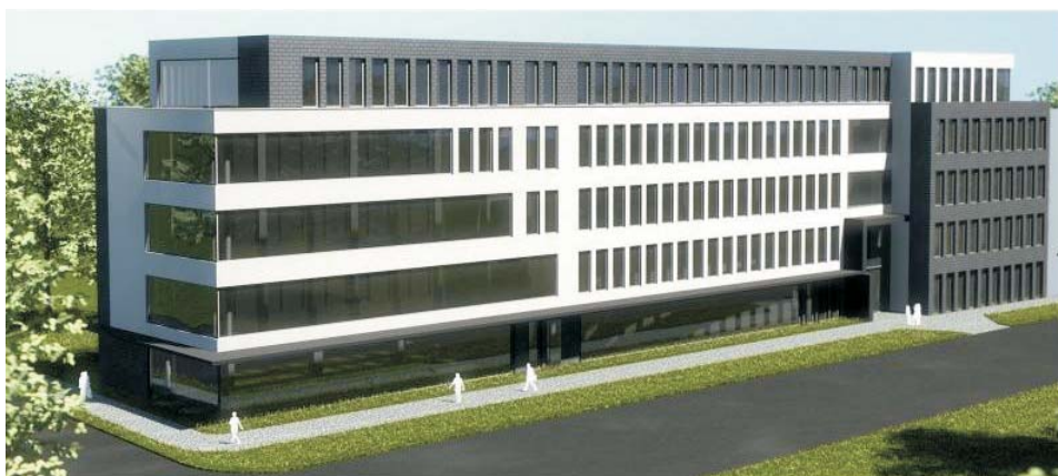
In der Poststraße neben den Stadtwerken befindet sich derzeit das Medicenter im Bau (Investor H. W. Pütz)
