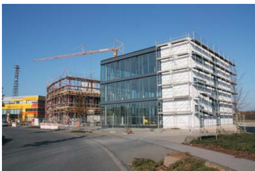
Im Airport Gewerbepark entsteht derzeit der „DHL Innovation Campus“
