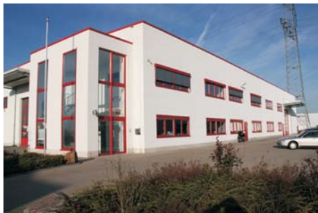
KWR Retzlaff (Erweiterung), Airport Gewerbepark Junkersring
