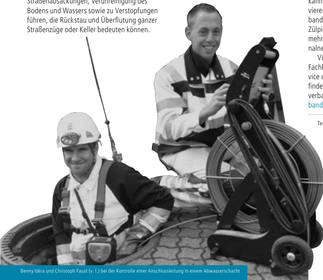
Benny Iskra und Christoph Faust (v. l.) bei der Kontrolle einer Anschlussleitung in einem Abwasserschacht
