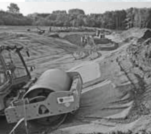
Herstellung der Dichtungsschicht und Aufbringung Kiesabdeckung für das neue Gewässerbett
