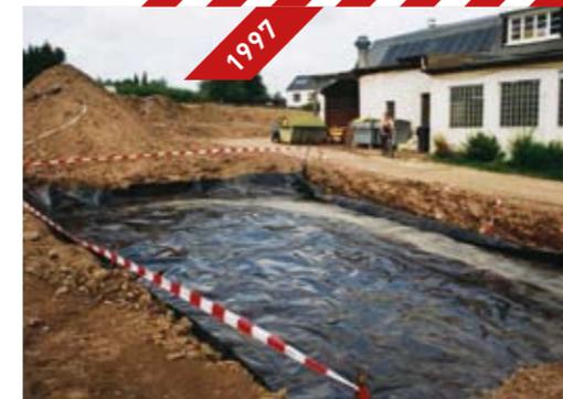
Sicherungsmaßnahme im Bereich der Bodensanierung durch Folienabdeckung
