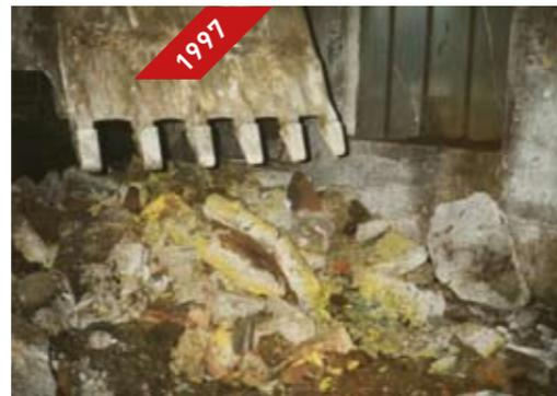
Rückbau der ehemaligen Galvanik im Produktionsgebäude der Eisengießerei Meskendahl; hier: Separierung des kontaminierten Bau-schutts mit gelb gefärbten Chromatausblühungen
