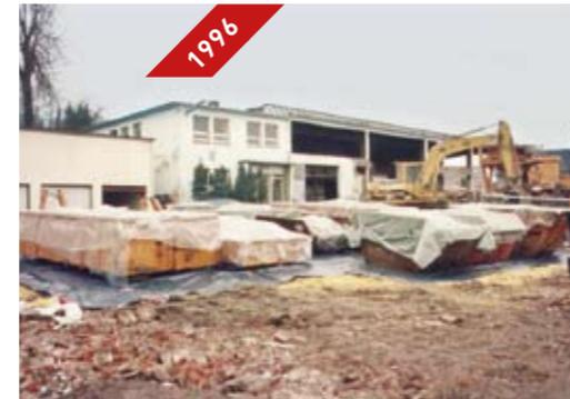
Bodensanierung durch Auskoffnung im Bereich der ehemaligen Galvanik im Produktionsgebäude der Eisengießerei Meskendahl
