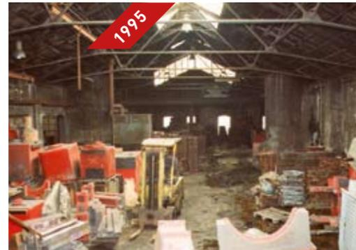
Rückbau der Eisengießerei Meskendahl an der Wiesenstraße, hier: Zwischenlagerung der kontaminierten Gebäudeteile zur Entsorgung
