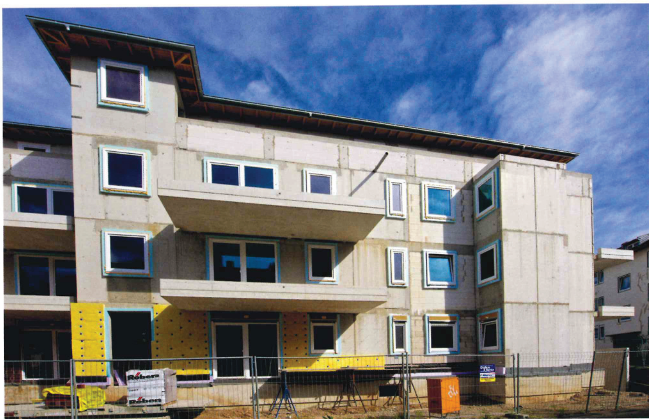
Baustelle des Neubauvorhabens Wiedemann- / Offenbachstraße, Bonn-Rüngsdorf
