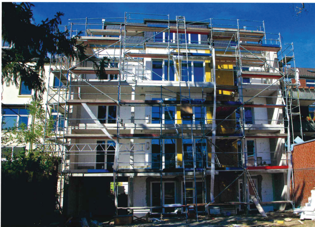
Baustelle des Bauvorhabens Ellerstraße 40, Bonn-Nordstadt
