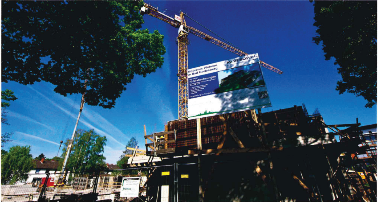
Baustelle des Neubauvorhabens Viktoria- / Wurzerstraße, Bonn-Plittersdorf
