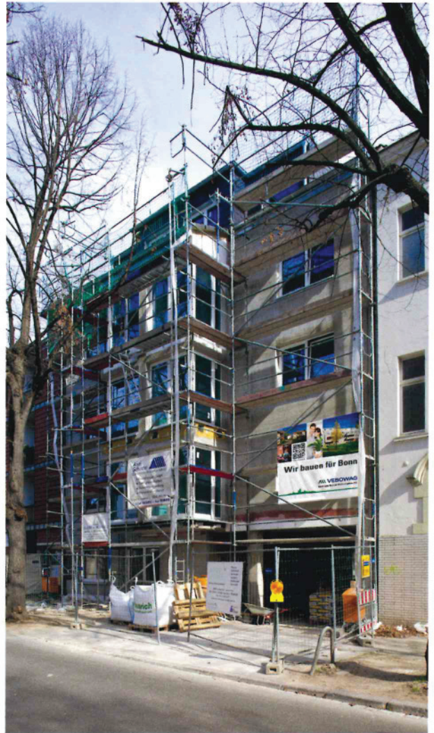
Baustelle des Bauvorhabens Ellerstraße 40, Bonn-Nordstadt
