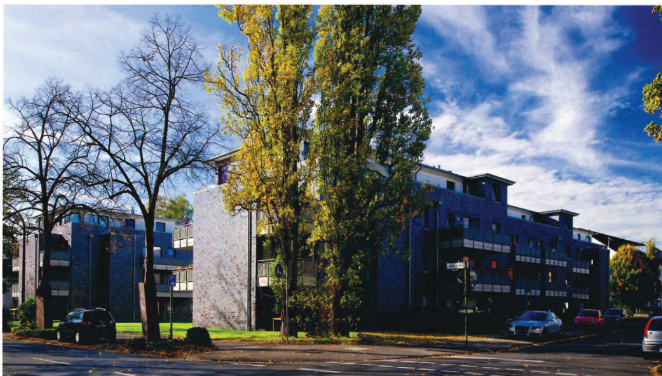
Fertigstellung des Neubauvorhabens Viktoria- / Wurzerstraße, Bonn-Plittersdorf
