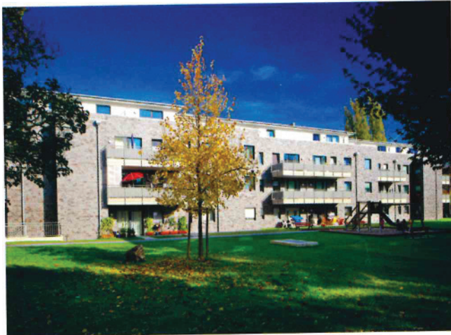
Fertigstellung des Neubauvorhabens Viktoria- / Wurzerstraße, Bonn-Plittersdorf
