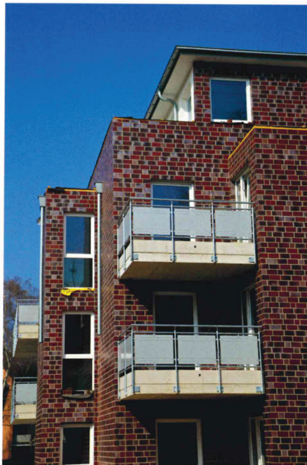
Baustelle des Neubauvorhabens Wiedemann- / Offenbachstraße, Bonn-Rüngsdorf
