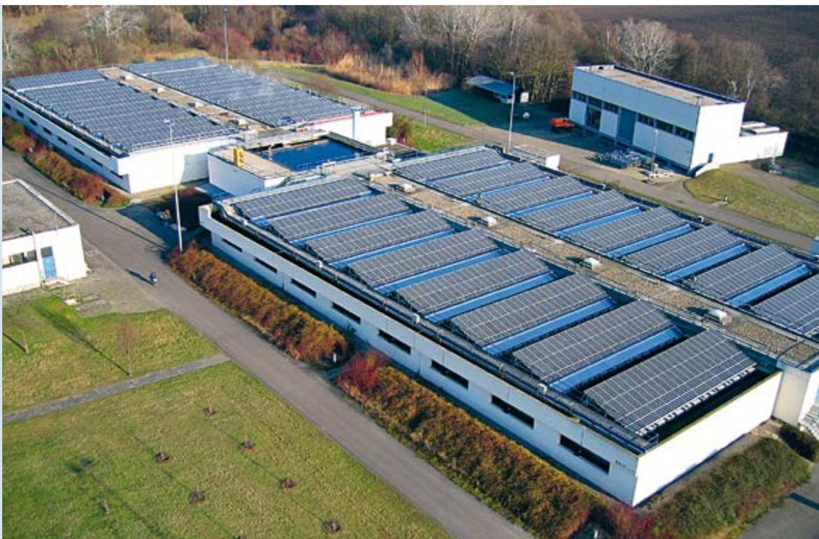
*Beschattung der Filtration mit aufmontierten Solarzellen*
