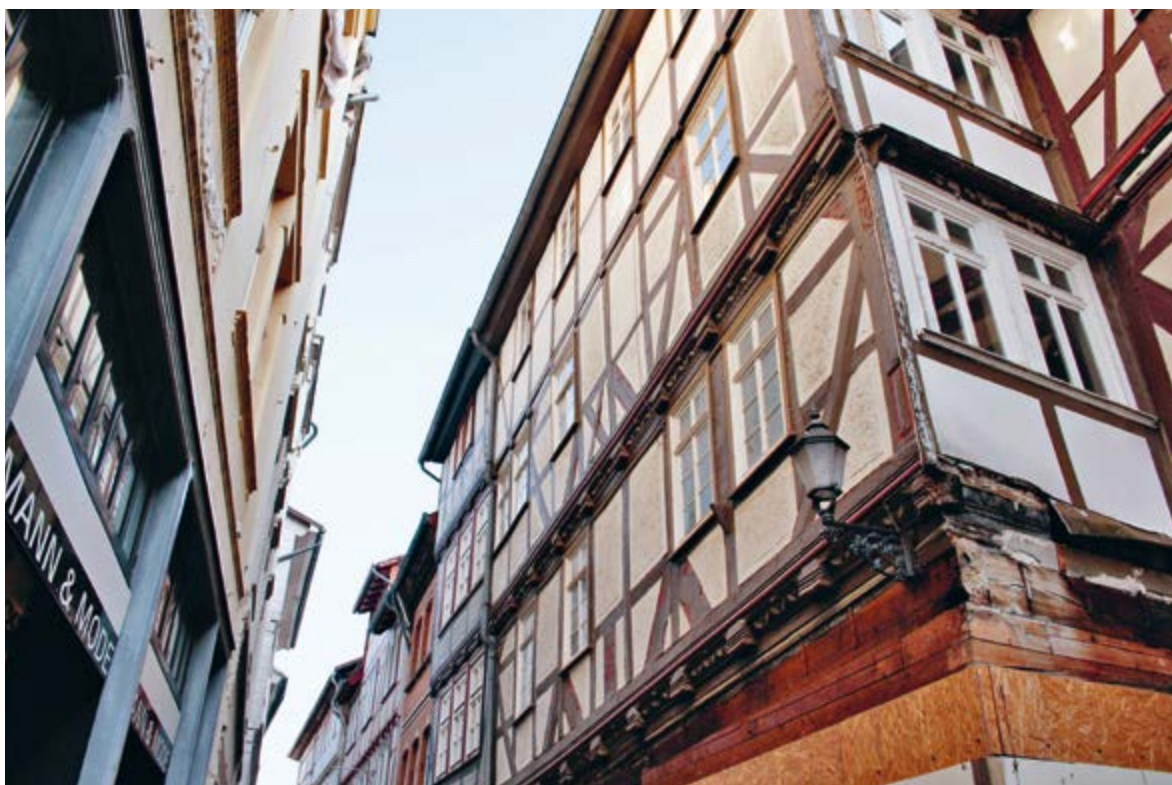
Herausforderung energetische Sanierung: Fachwerk in der Altstadt von Eschwege
