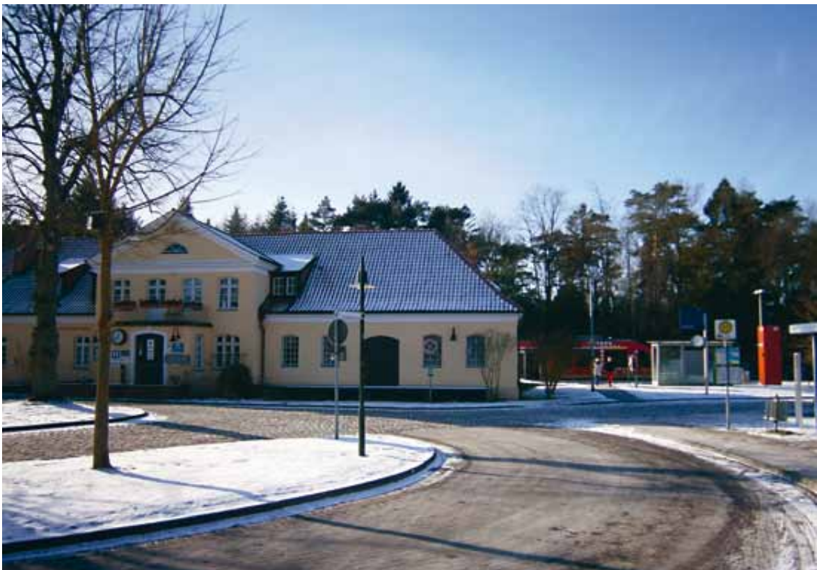
Energetisch sanierter und wiedereröffneter Bahnhof Pansdorf
