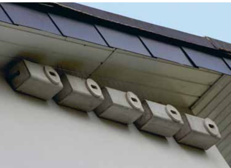
Einflugschlitze und Nisthöhlen für Mauersegler in sanierten Gebäuden
