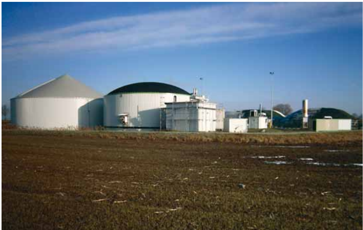
Biogasanlage mit Winterbegrünung nach Mais und Pflanzenkläranlage
