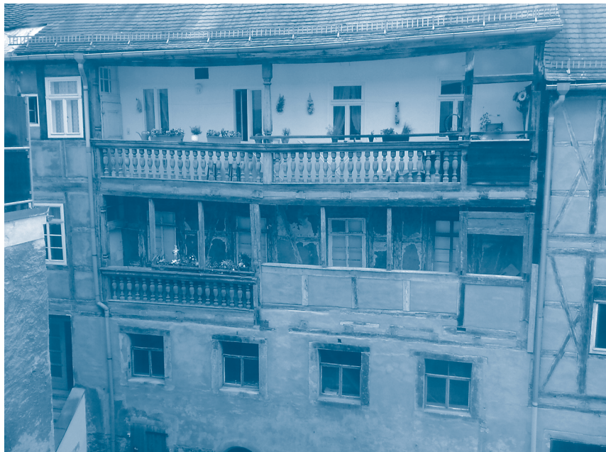
Abbildung 15: Ein typisches Element des Naumburger Stadtkerns sind mehrgeschossige Fachwerkhäuser mit ausgebauten Hinterhöfen (Foto: BTU Cottbus)
