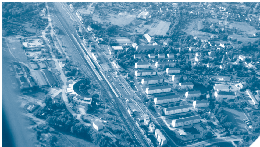
Abbildung 13: Blick auf den Teilraum Güterbahnhof (Foto: Jürgen Othmer)
