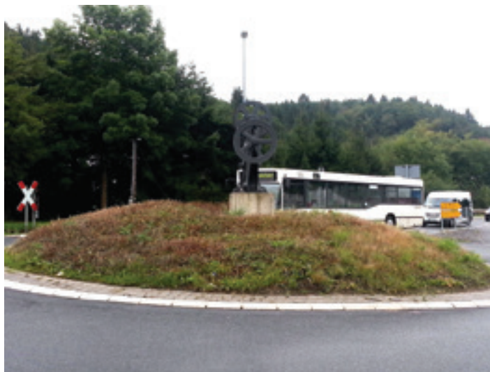
Kreisverkehr vor der Umgestaltung
