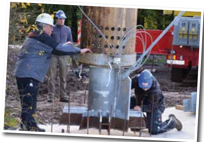
Ein mehrköpfiges Team aus Ingenieuren und Arbeitern ist am Aufbau des Turms beteiligt.
