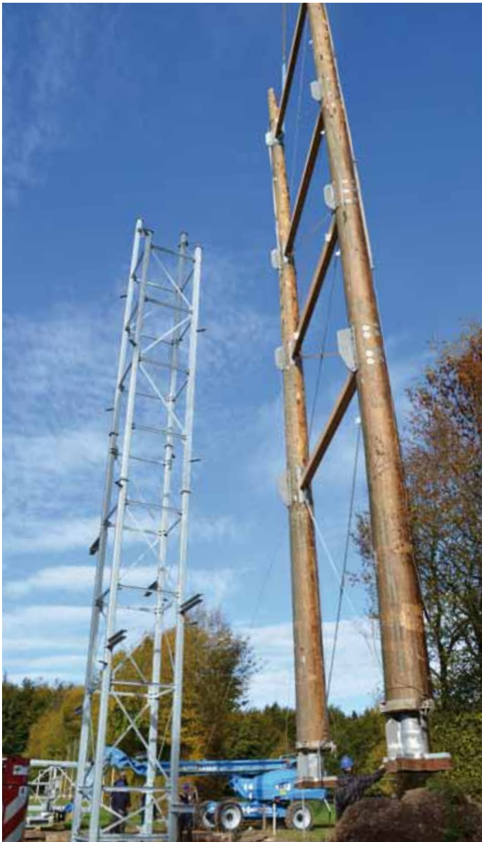
Der 500 t Mobilkran positioniert die ersten zwei Pfosten des neuen Turms. Das Treppenhaus wurde aus Stahl gefertigt.
