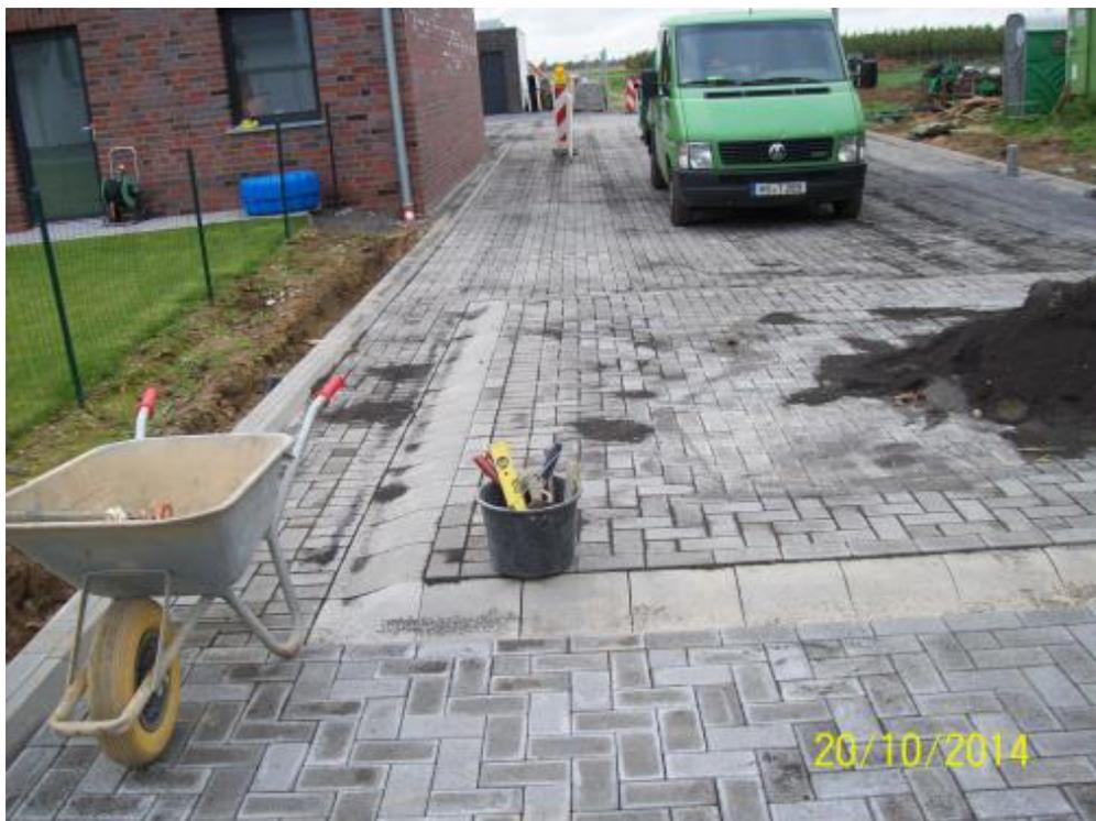
*Bild; Herstellung Fahrfläche mit „Drempel“ als verkehrsberuhigendes Element*
