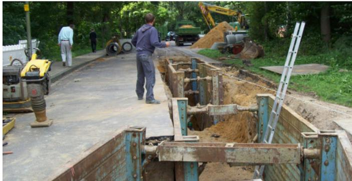
bestehende Kanal hydraulisch saniert. Im Anschluss wurden die Verkehrsflächen wieder hergestellt.
