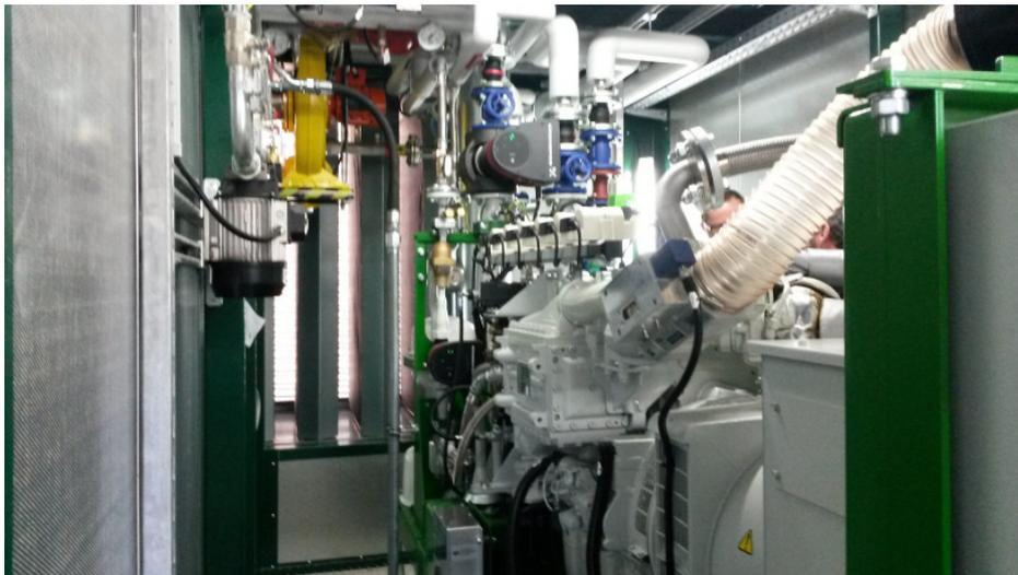
*Bild: Blick auf Gasmotor im Container mit Motorperipherie und Steuertechnik*
