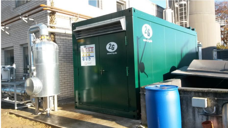
*Bild: eingehaustes BHKW mit vorgeschalteter Gaswäsche*
