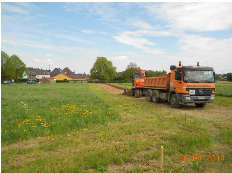
*Bild: Oberbodenabtrag zur Herstellung der Baustraßen*
