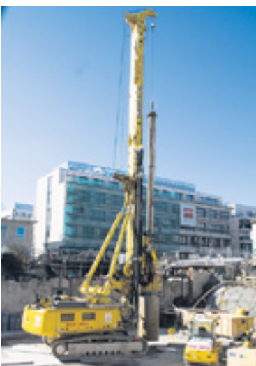
Das Bohrpfehlgerät zählt zu den größten und schwersten in Europa
