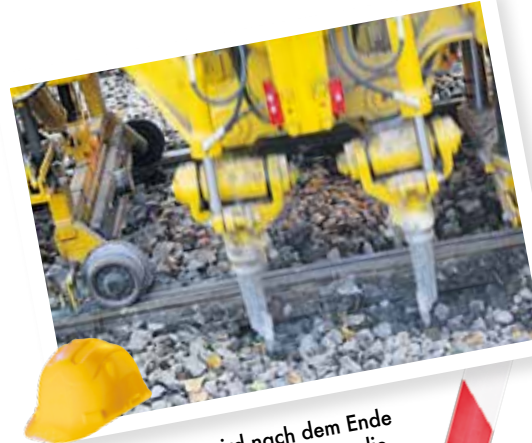
Das Gleisbett wird nach dem Ende der Maßnahmen gestopft, um die nötige Festigkeit zu erzielen
