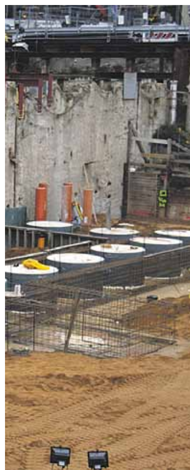
Bohrschablonen lassen erkennen, wie der Schacht gebaut wird
