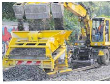
Mithilfe des Schotterreinigungsgerätes wird der Schotter vom Fremdmaterial getrennt
