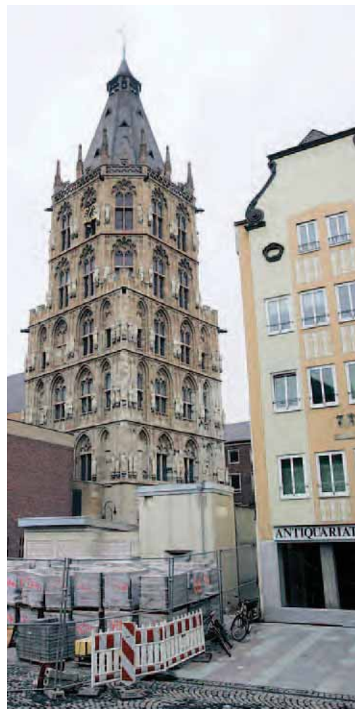
Hier entsteht die Haltestelle „Rathaus“.
