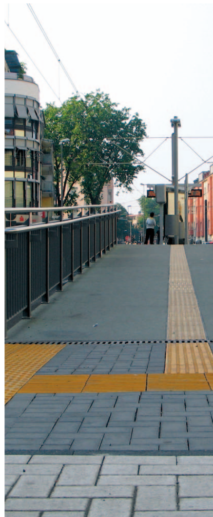
Dank neuer Bahnsteige, wie hier an der Illiststraße, kommt jedermann bequem in die Hochflurbahnen.
