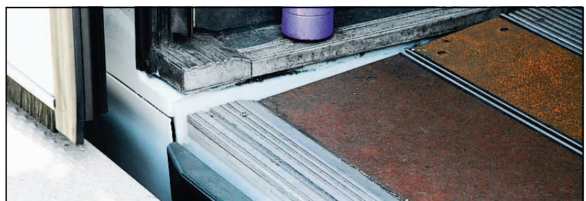
Eine leichte Schräge der Trittstufe ermöglicht den Rollstuhlfahrern ein nahezu problemloses Einfahren in die Stadtbahnwagen.
