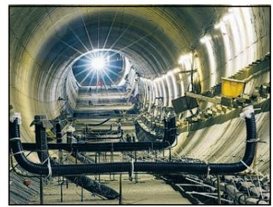
Rosa und Carmen aufgeföhren. Die Verbindung unter dem Museum Ludwig und der Philharmonie musste jedoch in einer herkömmlichen Bauweise erstellt werden: Bei tief in die Erde reichenden Wänden war die Durchfahrt für eine Schildmaschine zu eng. Da die notwendigen Arbeiten jedoch im Grundwasser ausgeführt werden mussten, wurde ein Druckluftverfahren für die Herstellung der beiden rund 100 Meter langen Verbindungstunnel gewählt, um zu verhindern, dass
