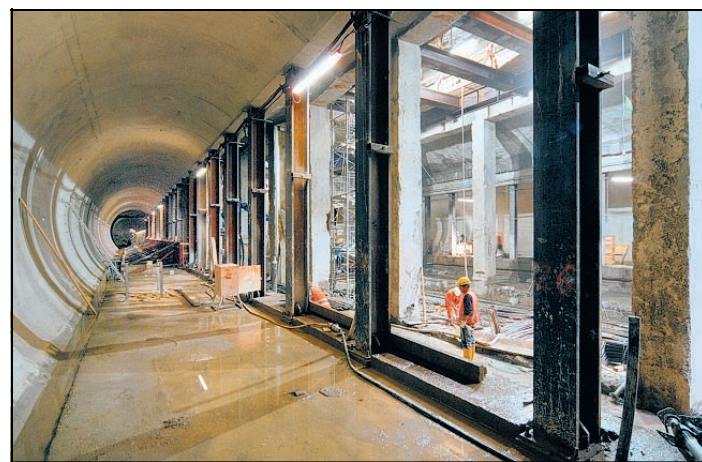
„Querschlag“ an der Haltestelle Chlodwigplatz: ein 18,50 Meter breiter Bahnsteig in 17 Metern Tiefe.
