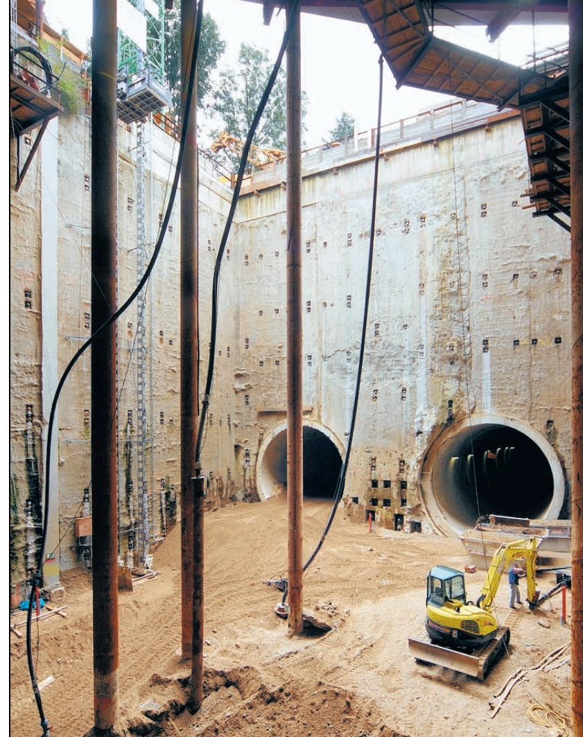
Zukünftige Haltestelle Heumarkt: Durch die aufragenden Rohre wird das Wasser aus unterirdischen Brunnen abgepumpt.
