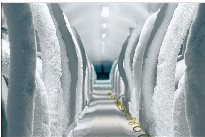
Um das Grundwasser fernzuhalten, wird das Erdreich zwischen Baugrube und Tunnelröhre vereist.
