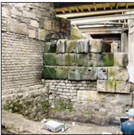
Die Reste der gefundenen Stadtmauer am Kurt-Hackenber-Platz werden auch für Besucher sichtbar gemacht. Insgesamt drei Millionen Euro werden dafür investiert.
