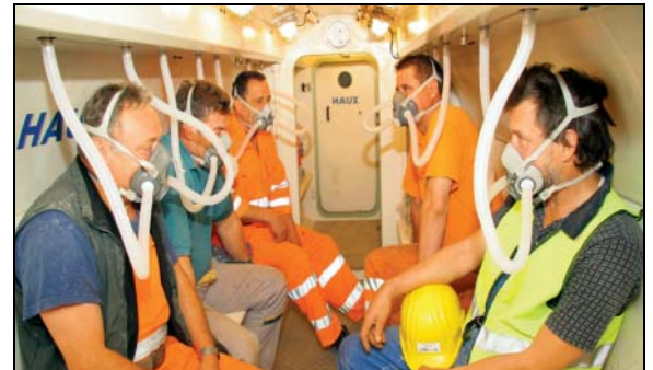
Beim Ausschleusen, wenn der Druck allmählich verringert wird, erhalten die Arbeiter mit Sauerstoff angereicherte Atemluft.
