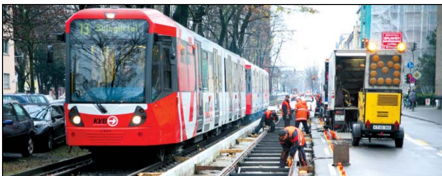
Ab Mitte März sollen die Bauarbeiten an der Linie 13 fortgesetzt werden.
