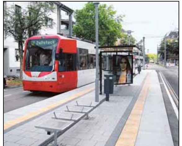
Im Stadtbahn-Standard: Die modernisierten Haltestellen der Linie 12 ermöglichen einen stufenlosen Einstieg in die Bahn.
