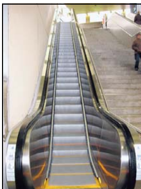
Die neue Treppe in Chorweiler.
