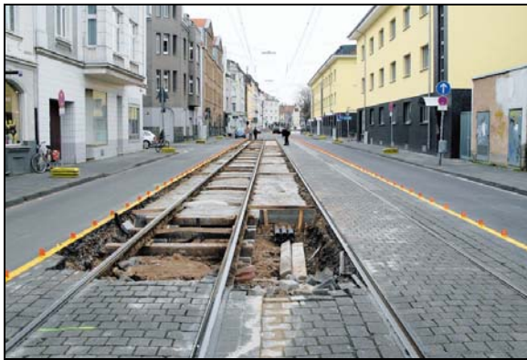
An der Linie 5 zwischen Parkgürtel und Landmannstraße werden auf über 500 Metern die Gleise und der Straßenbelag erneuert.
