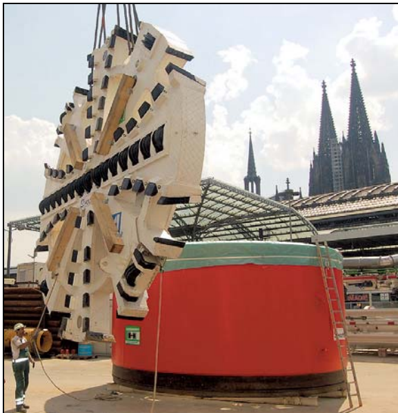
Mit diesem Schneidrad bohrte sich „Carmen“ durch den Untergrund in Richtung Philharmonie. (Bild: Rossi)
