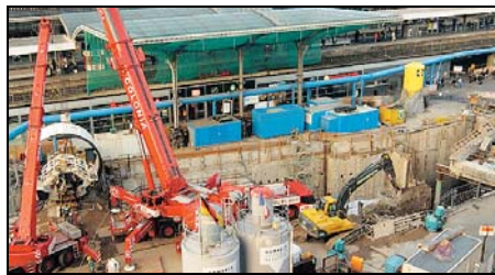
Der Startschuss des Alexandra-Tunnels unmittelbar hinter dem Hauptbahnhof. (Bild: Seelbach)
