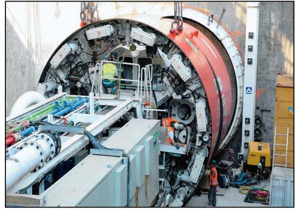
Die Tunnelbohrmaschine „Carmen“ wird für ihren nächsten Einsatz – Aufbohrung der Tunnelröhre West – vorbereitet.
