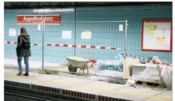
Ein weiterer Schritt in Richtung komplettes stufenloses Einsteigen auf allen Strecken des Stadtbahn-Netzes wurde im Oktober getan. In der Zeit vom 9. bis 15. Oktober wurden die Bahnsteige der U-Bahnstation „Appellhofplatz“ angehoben, so dass nun nach erfolgtem Umbau ein komfortables und bequemes stufenloses Betreten der Fahrzeuge möglich ist. Gleichzeitig erfuhr auch die „Poststraße“ eine Anhebung der Bahnsteige. Noch im Gange sind die Fliesenarbeiten.
