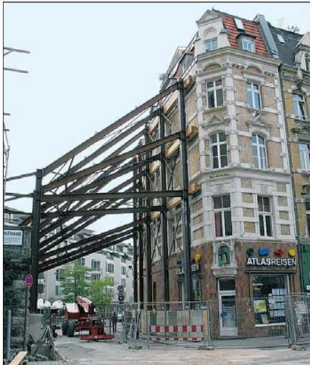
Kein Zeichen von Gefahr, sondern von sorgfältiger Fürsorge: Bei diesem schönen, alten Haus wird vorsorglich die Fassade auf Höhe der Etagenböden abgestützt.
