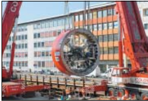
Riesige Krane hoben „Carmen“ in die Baugrube ...
