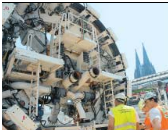
Hinter dem Hauptbahnhof am Breslauer Platz ist „Carmen“ mit allen Teilen schon im so genannten Anfahrtschacht eingehoben.
