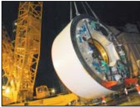
Millimeter-Arbeit war gefragt, um die schweren Teile von Tosca abzuladen und im Schacht zu montieren.
