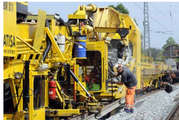
Thermitschweißen: Vorbereiten der Schienenenden zum Verschweißen
