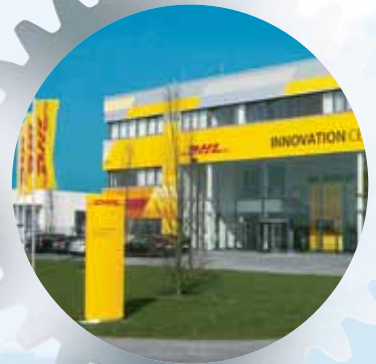
Das DHL Innovation Center im Airport Gewerbepark Junkersring
