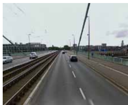
Severinsbrücke: autogerechten Stadt
