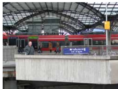
Am 29. Juli wurde der barrierefreie Zugang zum Hauptbahnhof über Gleis 1 abgerissen.
