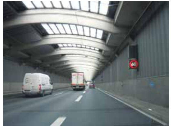
Autobahntunnel in Köln-Lövenich
