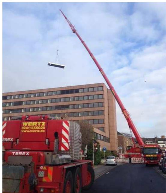
Installation der Kältemaschine nach Sanierung des Flachdaches Haus B im Rahmen des Klimaschutz-Teilkonzeptes
