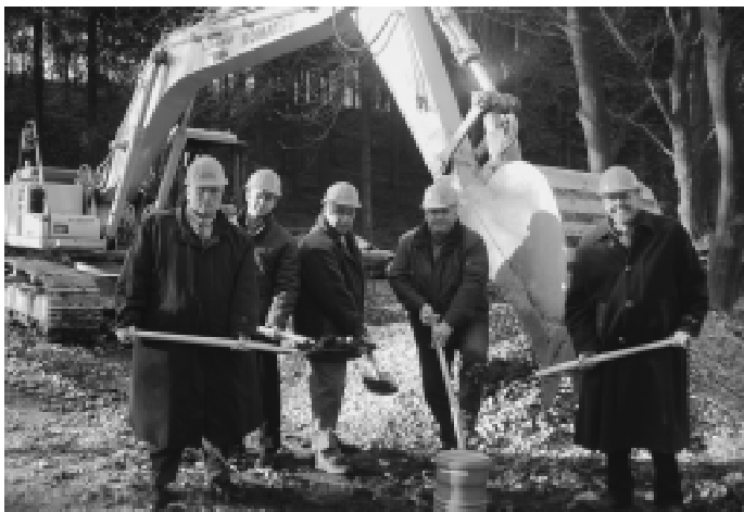
Bürgermeister Reuber (r.), Bauausschussvorsitzender Obemier (l.), Geschäftsführer Enders sowie die Bauleiter Thiel und Kleine beim ersten Spatenstich in Überasbach. Foto: C. Buchen
