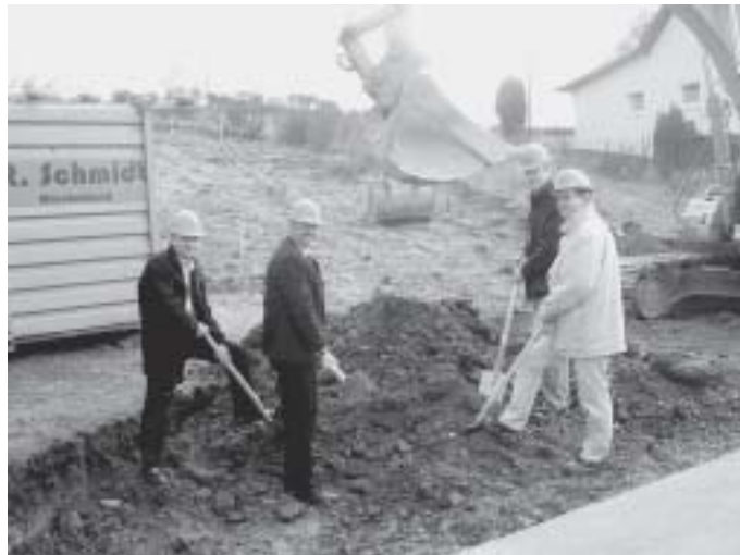
Die Einmündung der Straße „Im alten Ort“ in Appenhagen an die L 94 soll jetzt sicherer werden. Bürgermeister Reuber nahm zu Beginn der Umbaumaßnahmen den „ersten Spatenstich“ vor.
