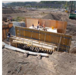
Die vier Phasen des Brückenbaus an der Querung Kampstraße: Vom Guss der Bodenplatte mit den hervorguckenden unterirdischen Betonpfählen links bis zur fast fertigen Schalung rechts gab es immer wieder Baufortschritte zu beobachten.
