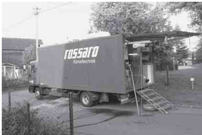
Die Firma Rossaro bessert in den nächsten Wochen Schäden am unterirdischen Kanalnetz der Gemeinde Morsbach aus.
