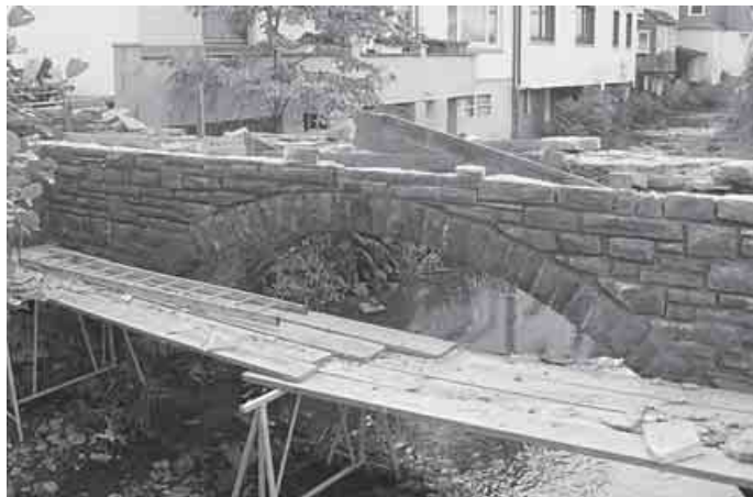
Die alte Bruchsteinbrücke über den Morsbach wird derzeit renoviert. Foto: C. Buchen
