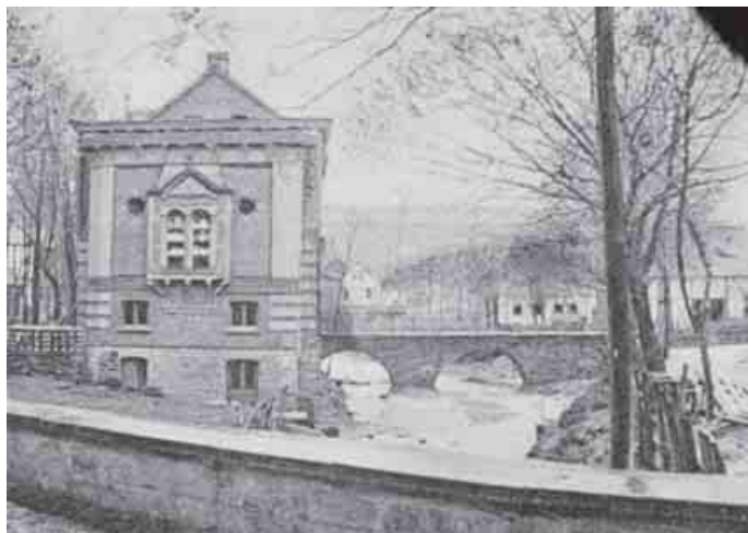
Vor der letzten Renovierung in der ersten Hälfte der 50er Jahre hatte die Brücke zwei Bögen. Das Foto zeigt eine Aufnahme von 1910. (Quelle: Bildband „Alt Morsbach“)
