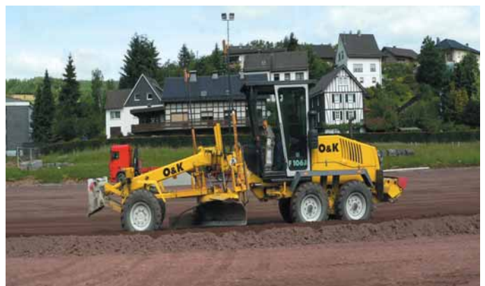
Mit einem „Cräter“ wurde die alte rote Aschendecke „abgeschält“, um den Sportplatz „Auf der Au“ für die neue Kunstrasendecke vorzubereiten. Fotos: C. Buchen
