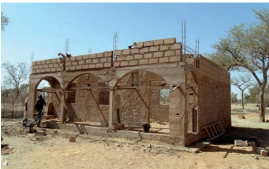
Abb. 8 2014: Der neue Kindergarten im Bau.
