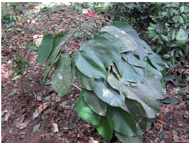
Abb. 3 Errichten einer traditionellen Rundhütte, gedeckt mit großen Blättern.
