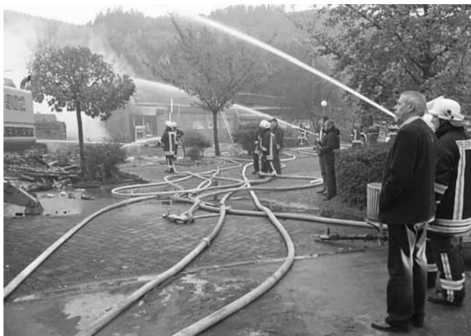
Bürgermeister Raimund Reuber war sehr betroffen und verfolgte die Lösch- und Abrißarbeiten.
