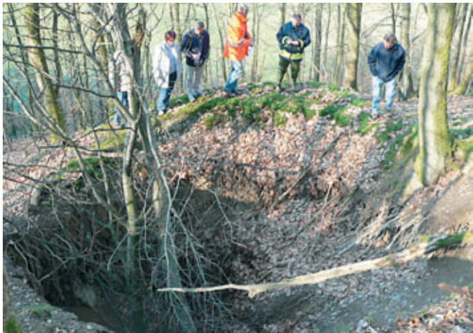
Bei dem schwallartigen Wasseraustritt war in der Nähe der Grube Magdalena auch ein Lüftungsschacht abgerutscht, der gesichert werden mußte.
