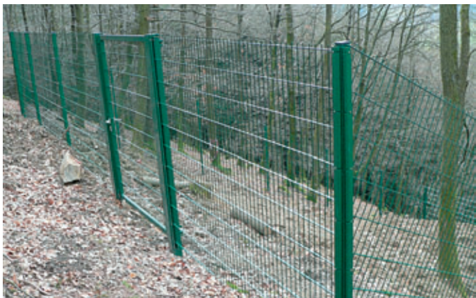
Dieser „Tagesbruch“ über dem Lüftungsschacht wurde mit Füllmaterial und einem stabilen Zaun nunmehr gesichert.
