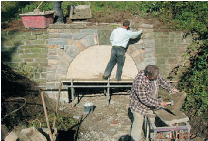
Auch das bruchsteinerne Stollenmundloch, das unter Denkmalschutz steht und unter dem Wasseraustritt gelitten hatte, wurde im Rahmen der Sicherungsarbeiten saniert.
