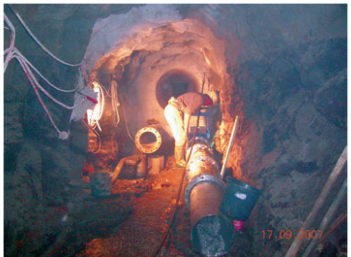
Die Herrichtung des Dammbauwerkes in ca. 230 m Stollentiefe. Es soll nun die schadlose Ableitung des anfallenden Grundwassers gewährleisten.
