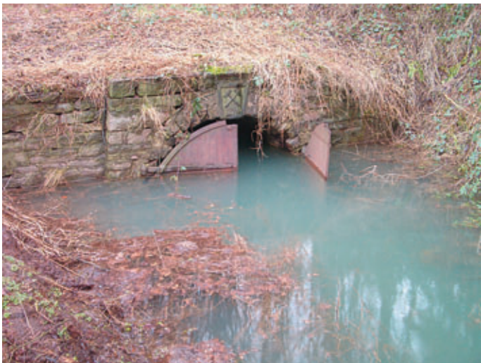
Ansicht des gleichen Stollenmundlochs der Grube Magdalena nach dem schwallartigen Wasseraustritt im Januar 2005. Das Wasser stand fast bis zum Schlussstein, der mit den Bergbausymbolen „Hammer und Schlägel“ und der Jahreszahl 1890 versehen ist. Fotos: C. u. H.-G. Buchen
